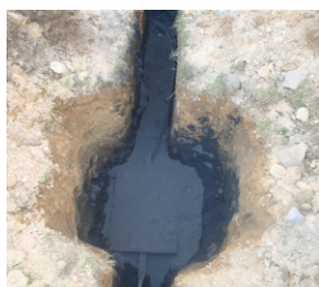
接地模块与降阻剂施工
