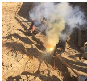
接地棒与铜排放热焊接
