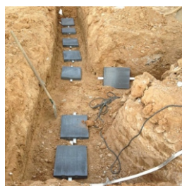
方形接地模块施工
