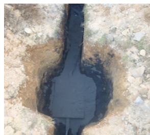
接地模块与降阻剂施工
