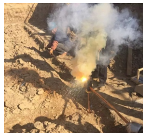
接地棒与铜排放热焊接
