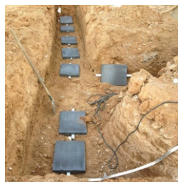
方形接地模块施工
